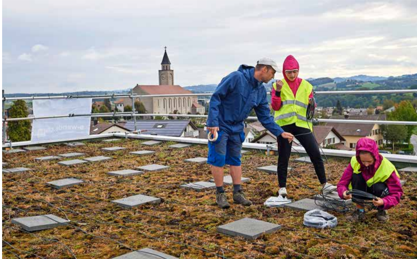
Schüler und professionelle Installateure arbeiten gemeinsam am Bau der Solaranlage.
